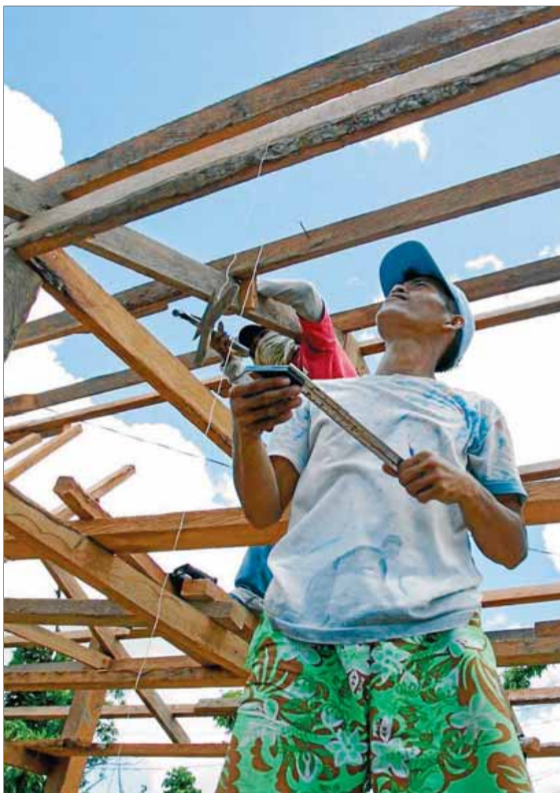
Construcció d'habitatges a les Visayas, a les Filipines ■ CARITAS INTERNATIONALIS
